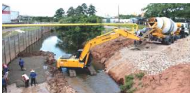
Obras tiraram casas das margens e ampliam o leito do arroio Sapucaia
