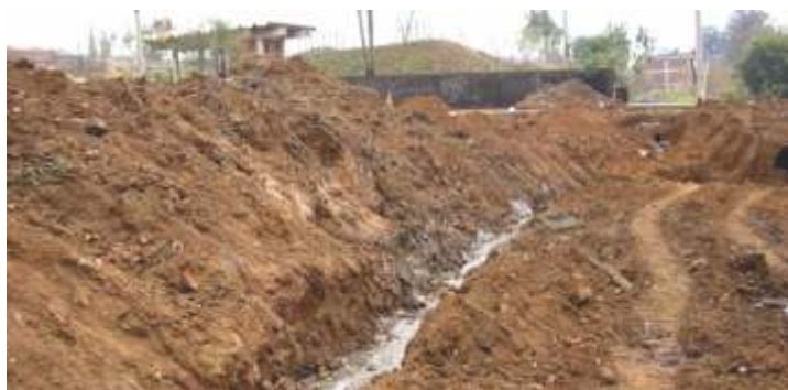
O córrego Tijuco Preto estava tampado perto de sua nascente
