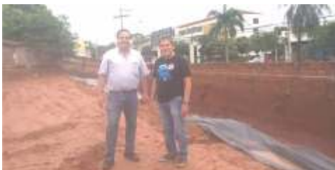
Eng. Kurimori e Eng. Vicente vistoriam obra em andamento
