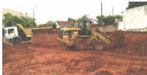
Maquinas realizam escavações no terreno
