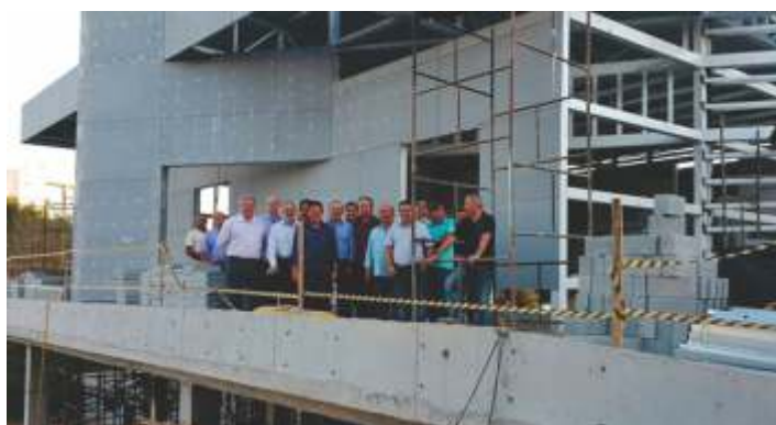
Imagens do Eng. Francisco Kurimori e Lideranças Regionais vistoriando obras do CREA-SP
