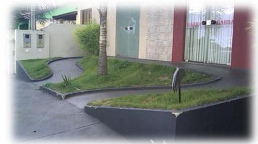
Imóvel que as rampa não atende inclinação - NBR 9050
